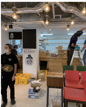
工事状況を確認する永野店長
